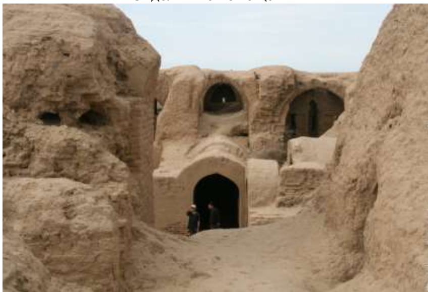
Кладка сырцовых кирпичей
