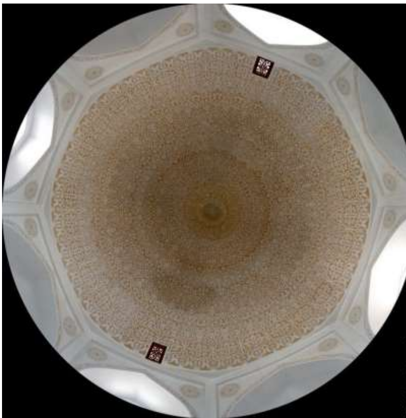
Декор купола усыпальницы в интерьере
