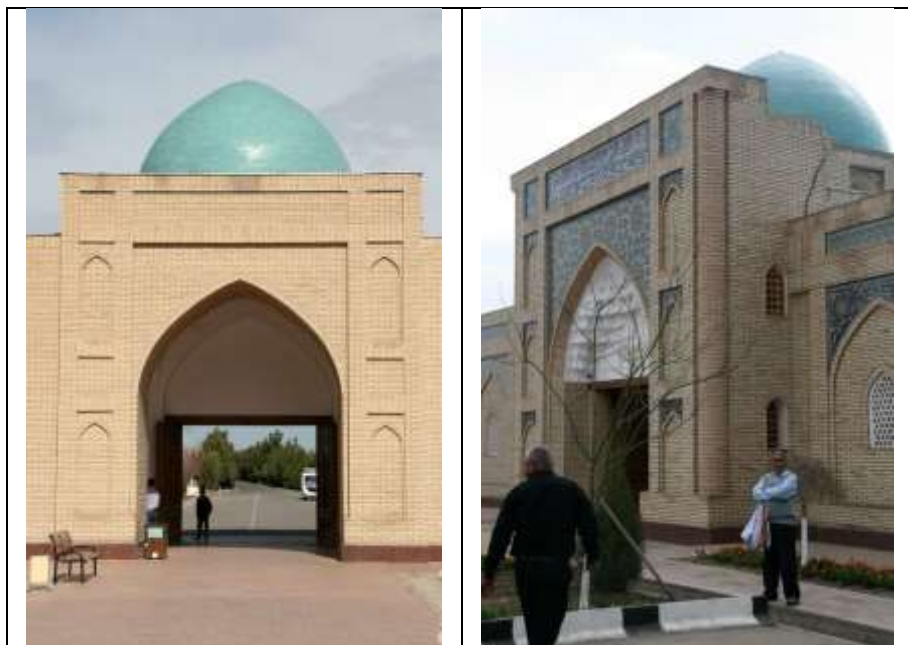
Фрагменты архитектурного комплекса Хакима ат-Тирмизи
