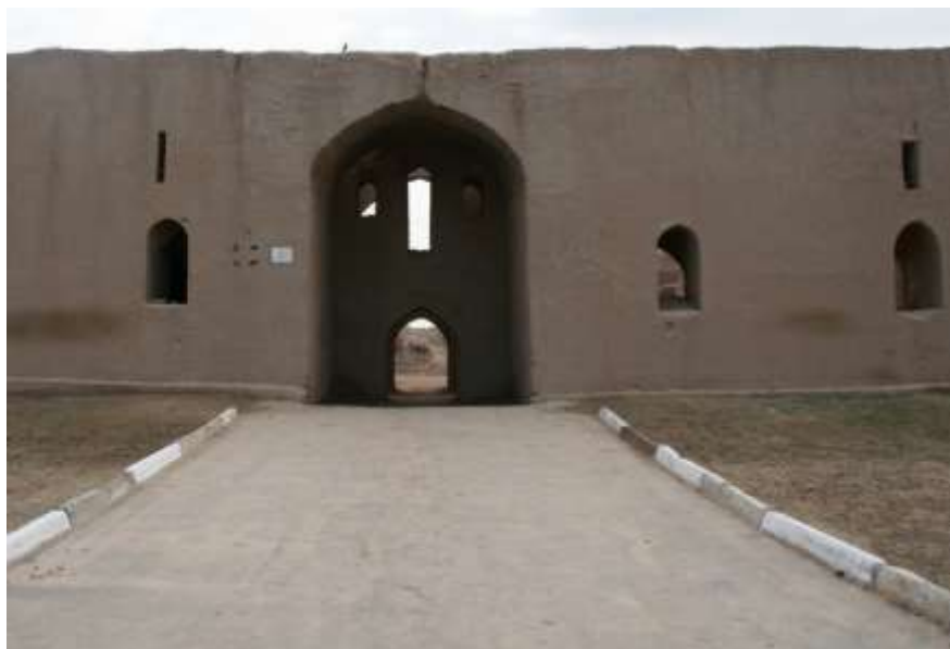
Входной арочный проем Кырк-Кыз
