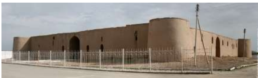
Общий вид Кырк-Кыз ч реставрацией стен
