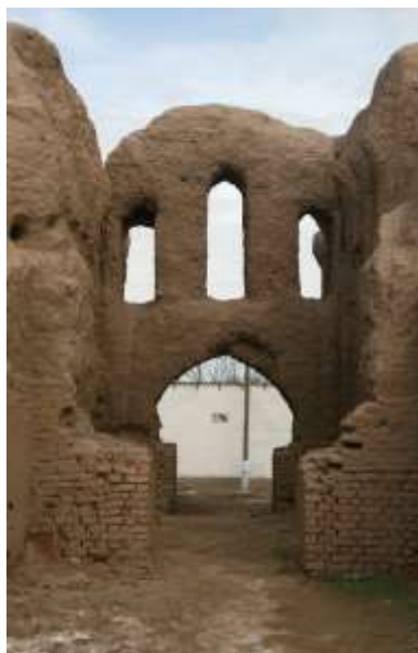
Арочный проход и арочные проемы
