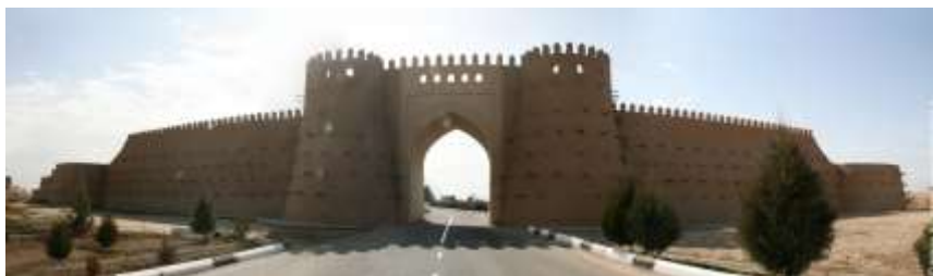
Реконструкция оборонительных стен с монументальными воротами и привратными башнями Старого Термеза
