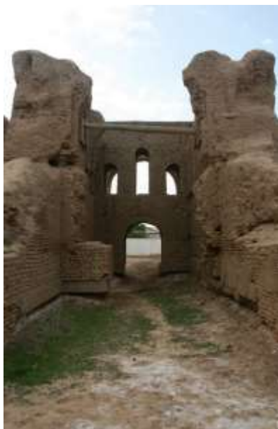
Внутренний входной коридор
