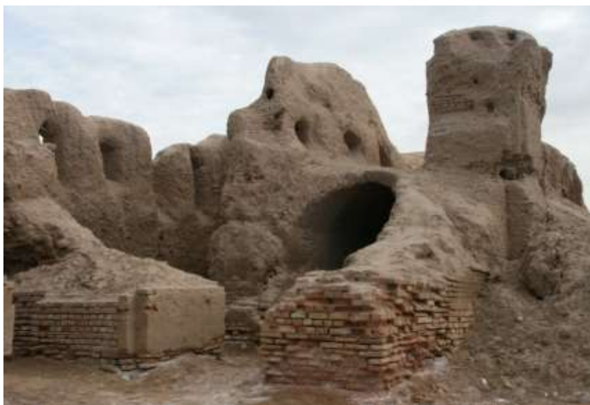
Фрагментарная кладка стен из жженного кирпича
