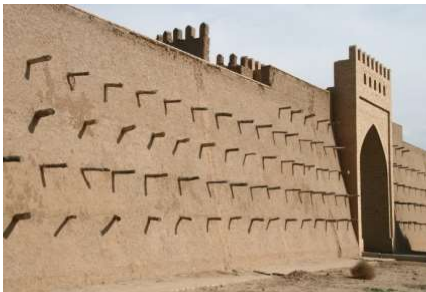
Наружные стены со входным арочным проем
