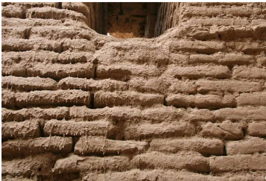
Кладка сырцовых кирпичей
