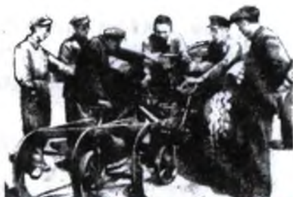
Озмоиши трактори хитой, ки бо иштироки мутахассисони Шуравӣ сохта шуда буд.
