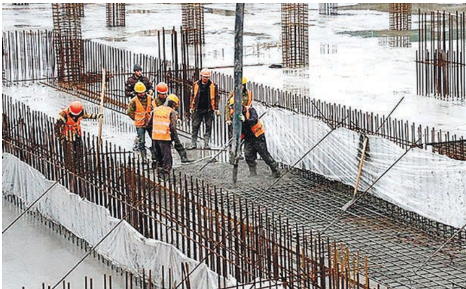
Расми 49. Барои муҳофизат аз заминҷунбӣ мустаҳкам кардани сохтмонҳо бо оҳану бетон
